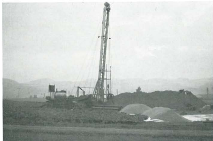
Bohrgerät bei der Bohrung des Tiefbrunnens 2 (Spülbohrung)
