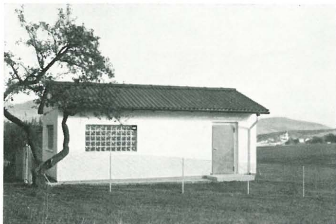
Druckbehälterpumpwerk in Steckenhof
