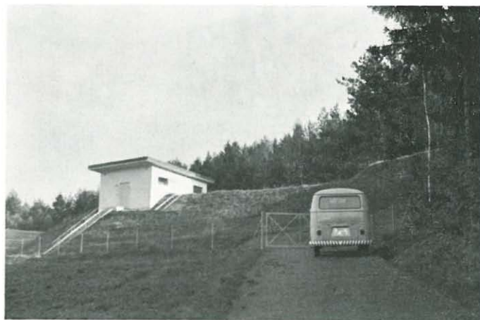
Hochbehälter 500 nach Fertigstellung
