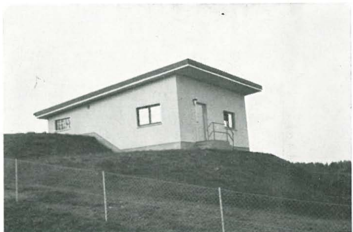
Hochbehälter 350 nach Fertigstellung
