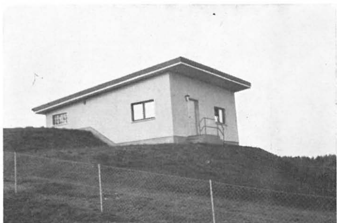
Hochbehälter 350 nach Fertigstellung
