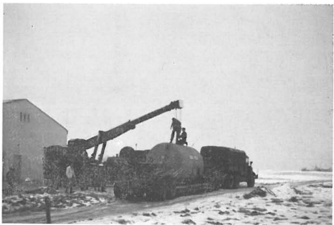
Transport der Filterkesseln
