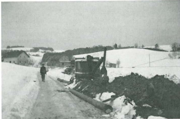
Verlegung der Hauptverbindungsleitung Hunderdorf-Mitterfels (Winter 1962 - 63)
