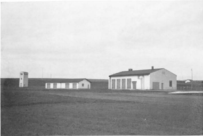
Hauptpumpwerk- Aufbereitungsanlage, Lagerhalle u. Trafostation in Hunderdorf
