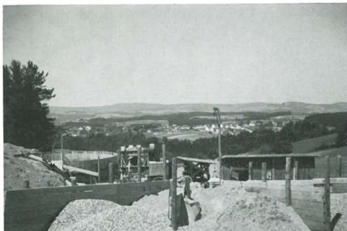
Hochbehälter 500 in Mitterfels im Bau
